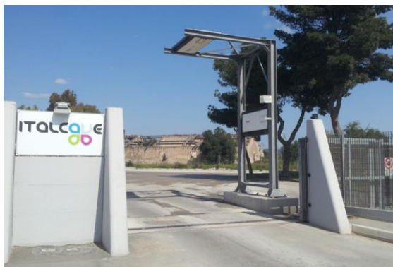
Fig. 36 - Portale radiometrico all'ingresso dell'impianto
